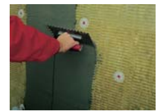
Vakolt homlokzati hőszigetelő rendszerekben alkalmazott homogén, egyrétegű kőzetgyapot lemez.
